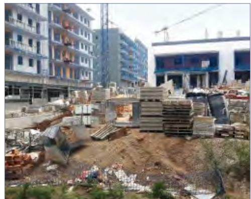
Figura 2. Obra de Edificio de Viviendas, año 2018
