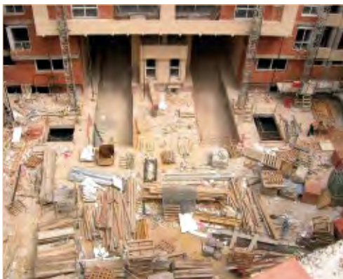
Figura 1. Obra de Edificio de Viviendas, año 2006
